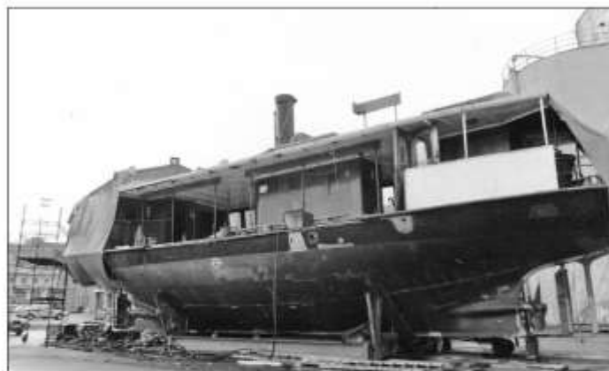
Från april 1981 till september 1985 stod färjan på Sörhallskajen för omfattande arbeten. När bilden togs är plåtbytena i skrovet klara och utbyte av babords överbyggnadssida pågår. Foto Åke Karlsson september 1984.
