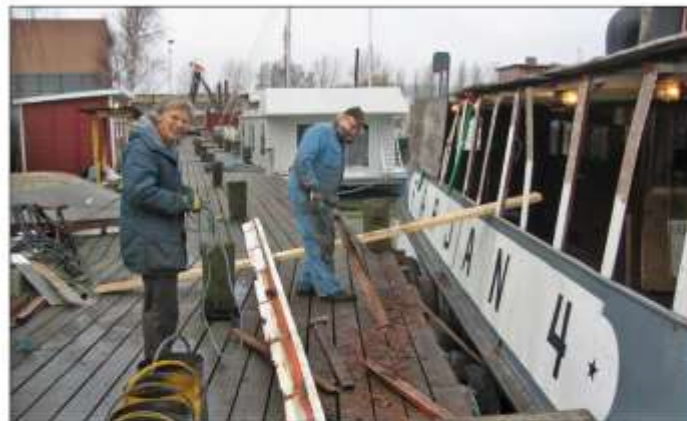
Rolf Nilsson och Bert Johansson river takkanten på styrbords överbyggnadsida. Hela överbyggnadsidan byggdes upp igen i egen regi med nytt eller reparerat material. Foto Gunnar Söderberg 6 december 2008.
