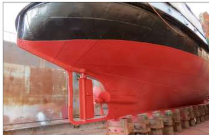
FÄRJAN 4 torrsattes i oktober 2018 på Götensius Varv för bottenbesiktning och bottenmålning. Här syns en del av det nitade skrovet. Foto Gunnar Söderberg.
