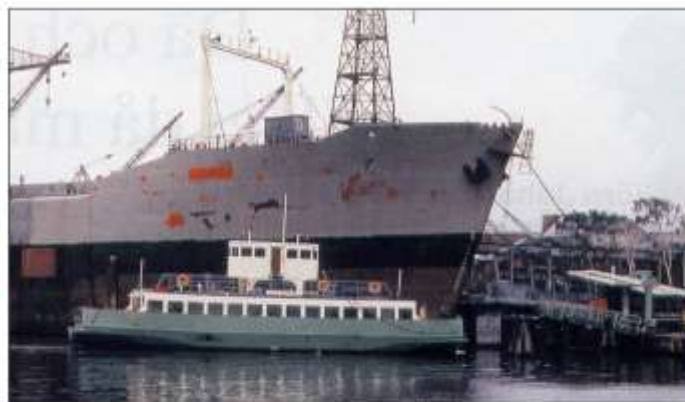
När HUGO HAMMAR ersatte FÄRJAN 4 i juni 1954 trafikerade den ett nytt färjeläge i Lundbyhamnens västra hörn. De sista åren fram till linjen nedlades i juli 1970 var FÄRJAN 4 åter i trafik med HUGO HAMMAR i reserv. Foto Ulf Bäckström.
